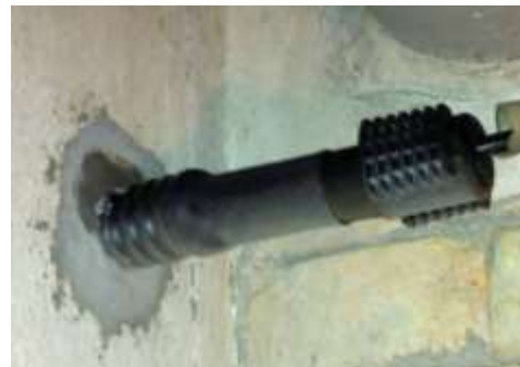
Abbildung 2: Wasserdichte Gebäudeeinführung für ein Kabelschutzrohr DN50 für mehrere Außenkabel.
